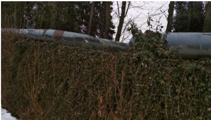
Obrázek 57: Nedodržení režimu v ochranném pásmu horkovodu
