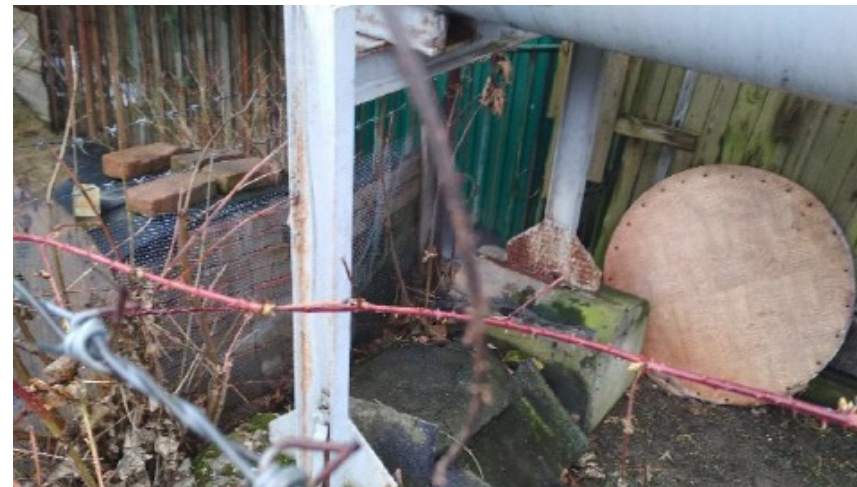
Obrázek 59: Nedodržení režimu v ochranném pásmu horkovodu
