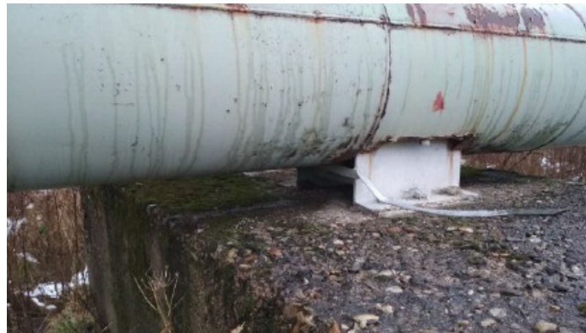
Obrázek 52: Přerušené ochranné uzemnění
