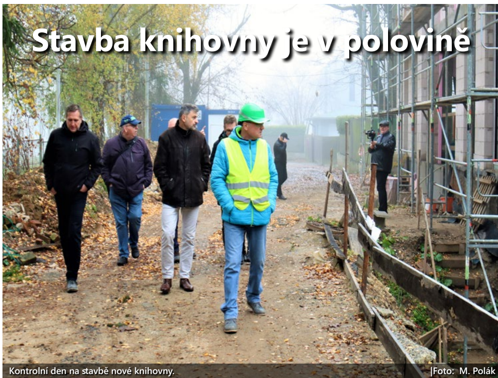
Kontrolní den na stavbě nové knihovny.
