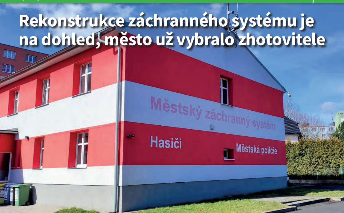
Budova městského záchranného systému.
